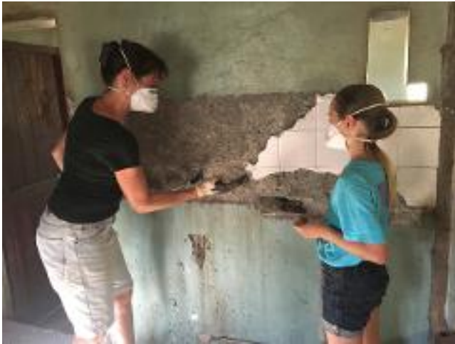
un peu de démolition !
