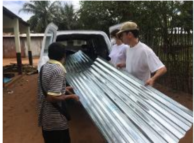
La nouvelle toiture
